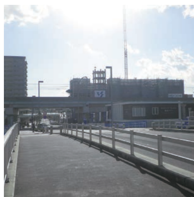
鳴海駅前JVプロジェクト新築工事現場
