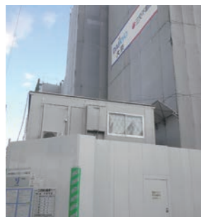
敷地内にある現場事務所
